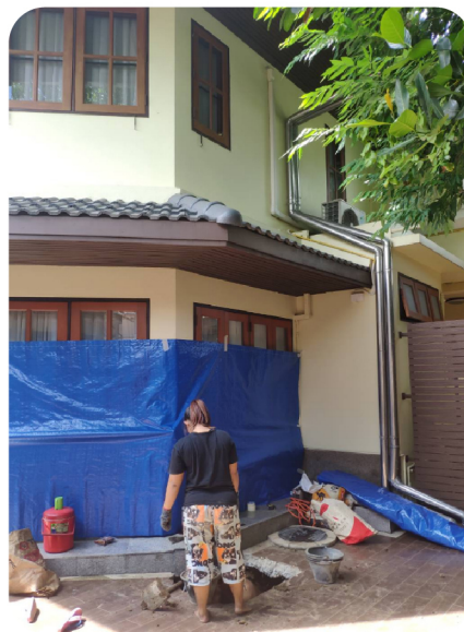
สองชั้นนี้ซ่อมได้ ทางเพราะเสาเข็ม จะมียื่นทุก ค.ร.ม.
